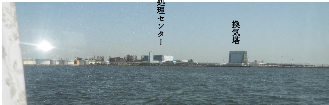
首都高速湾岸線浮島側換気塔と浮島処理センター
