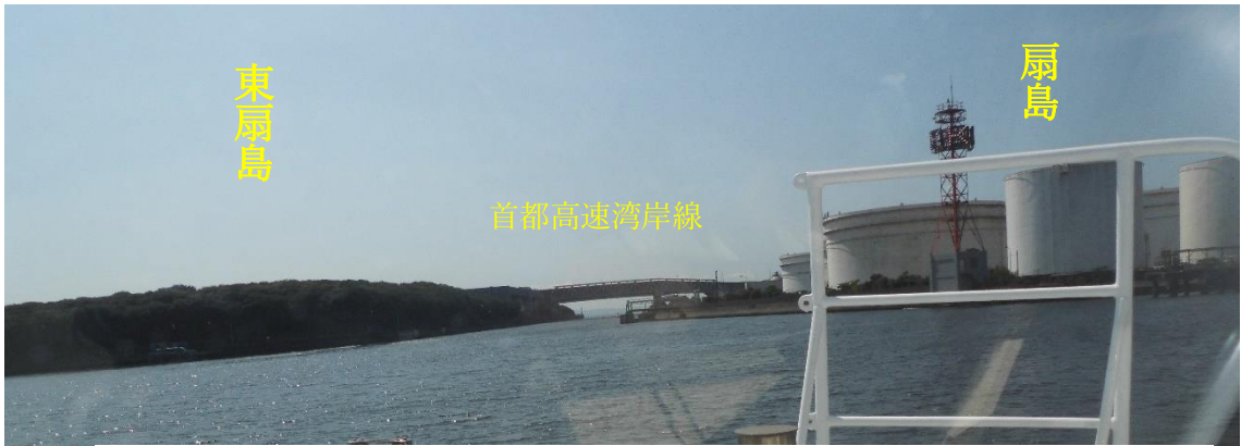
扇島水路。幅 70m、長さ 610m
