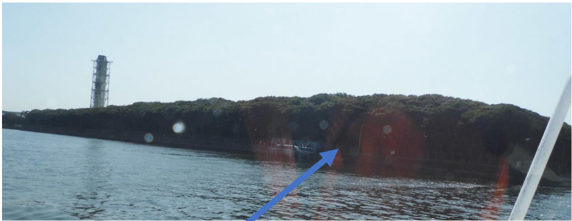
東京電力東扇島地下タンク。周囲が森に囲まれている。
