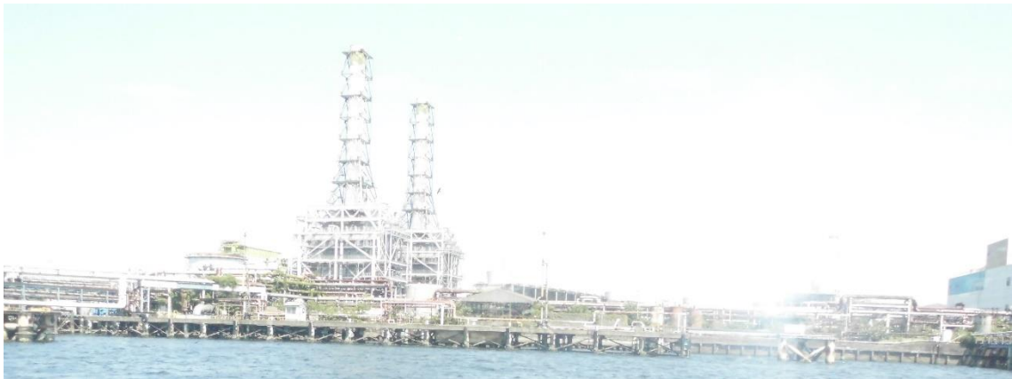
川崎天然ガス。総発電出力約 84.7 万 KW。工場夜景のスポットにもなっています。
