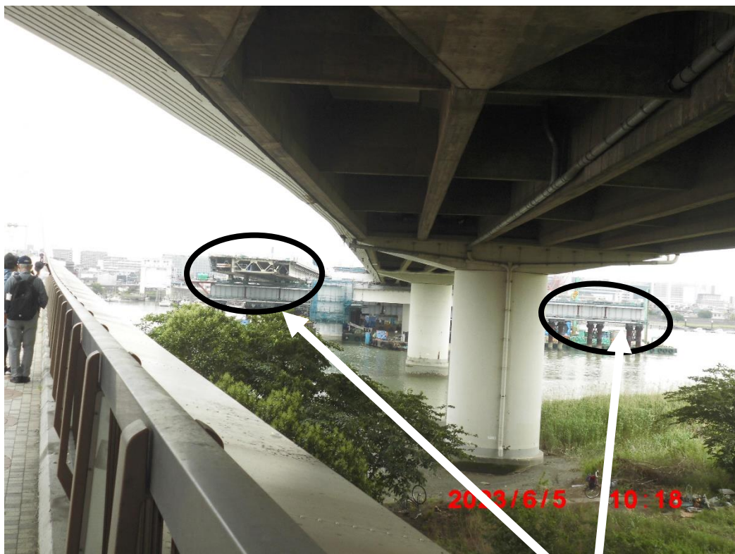
すでに桁の移動は終了していました。左手に見えるのが既設の移動桁。これを解体運搬して撤去。右手の仮構台（ベント）は新設の桁がスライド移動完了した状態。
