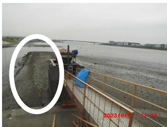
五十間鼻。多摩川本流と海老取川合流部の堤防強化のために河床に石を積んである。流れによって河床がえぐられないようにするため。先人たちの知恵ですね。ここには水難者のための無縁仏堂が祀られていました。
