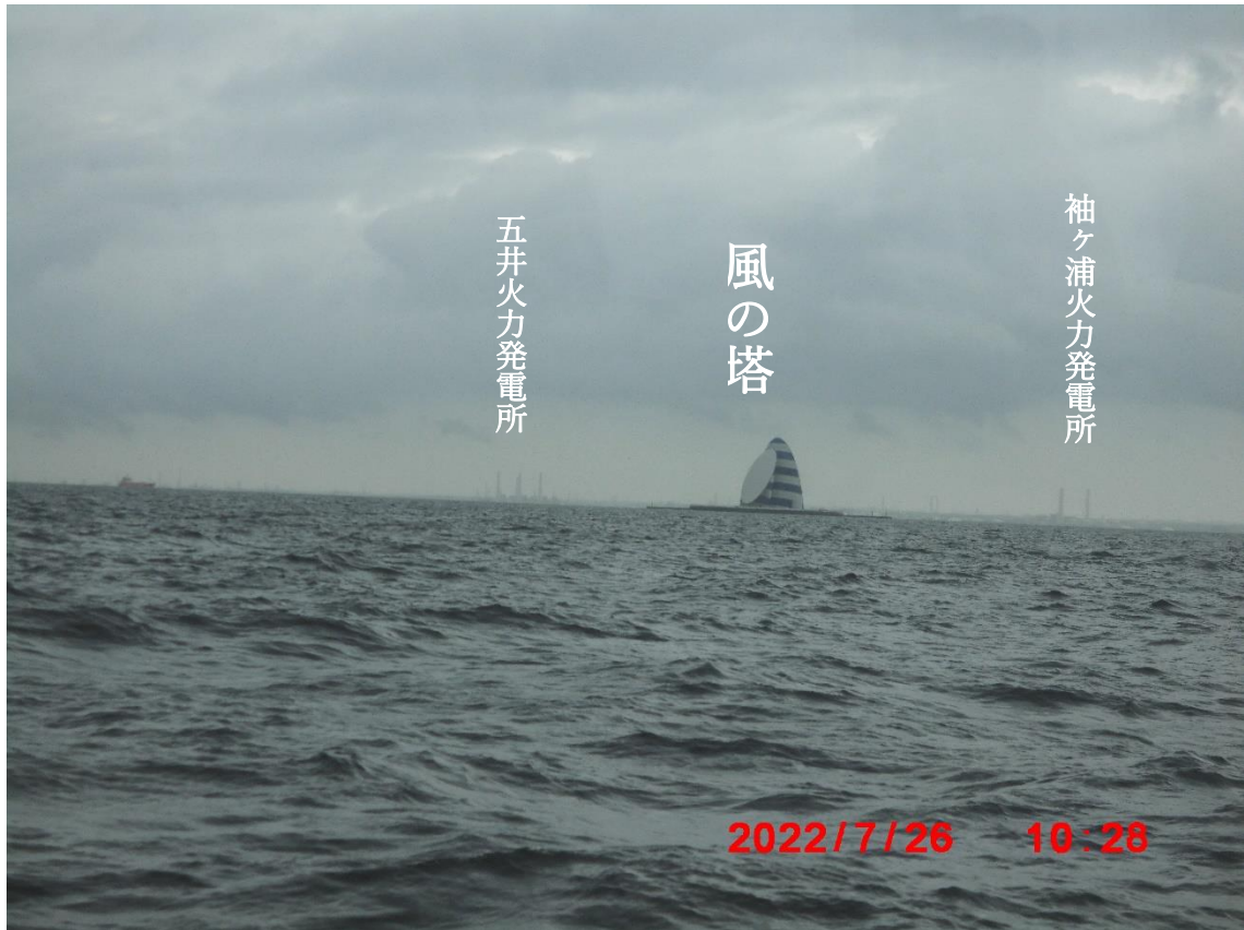
アクアラインの川崎方の風の塔。トンネルの換気の役割をしている。平山郁夫のデザインだそうです。千葉方面の火力発電所がうっすらと見えました。
