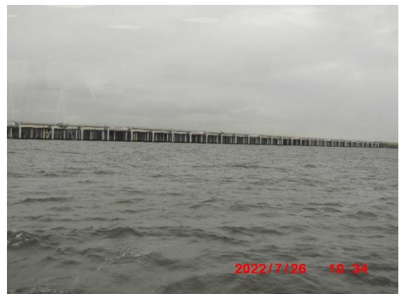
羽田空港 D 滑走路。直径 1.6m の鋼管杭を 70m の支持地盤まで打設し合計 1151 本の杭で航路の床板を支えているという。多摩川の流れを阻害しないように杭形式にしたという。
