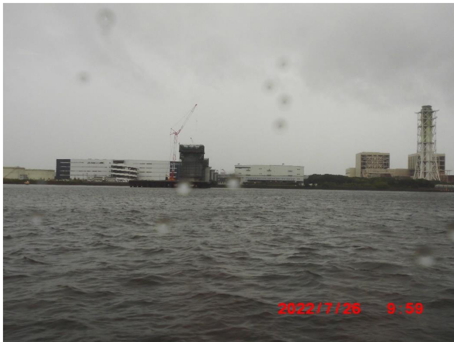
東扇島側橋梁部
