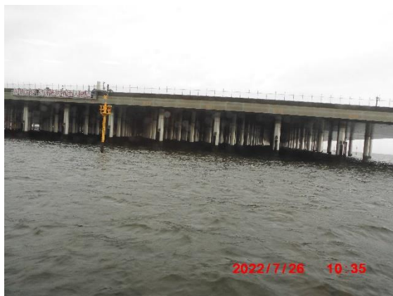
羽田空港 D 滑走路。直径 1.6m の鋼管杭を 70m の支持地盤まで打設し合計 1151 本の杭で航路の床板を支えているという。多摩川の流れを阻害しないように杭形式にしたという。
