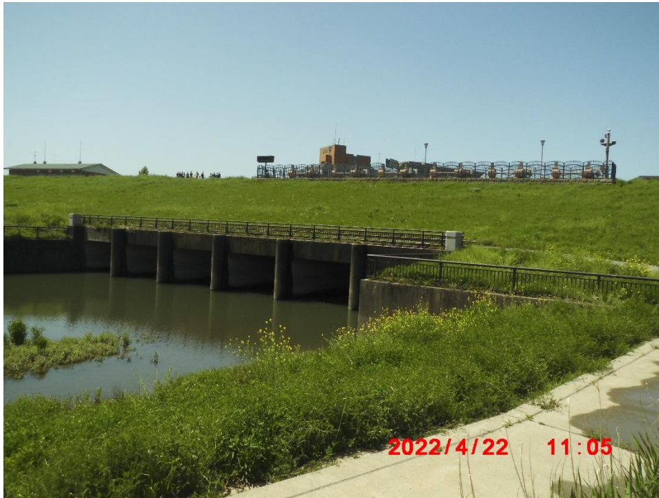
排水樋管幅 5.4m×高さ 4.2m×6門 パンプより
