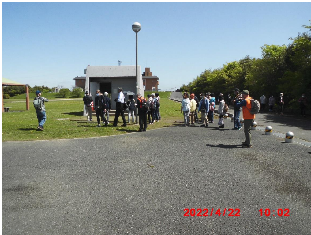
調圧水槽の入口。地下 116 段の階段を降りました。
