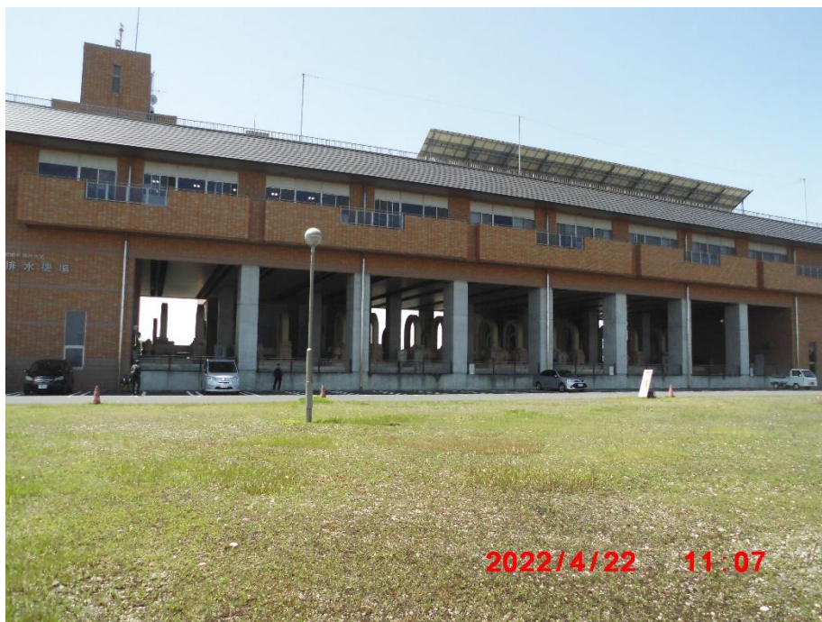
大型ポンプ4台で水をくみ上げて江戸川に放流
