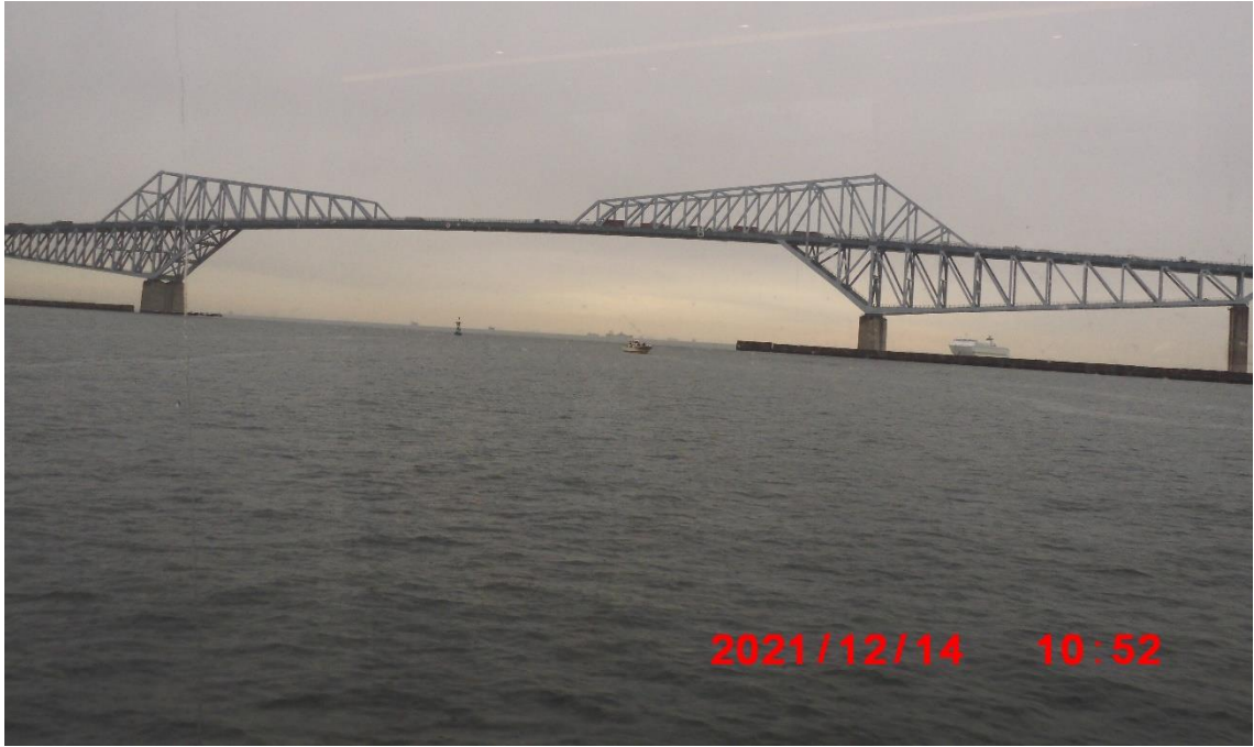
東京ゲートブリッジ
