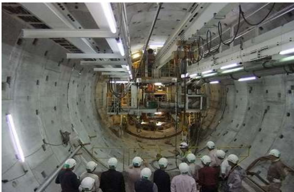
(写真9) シールド掘削、ここは最先端！
