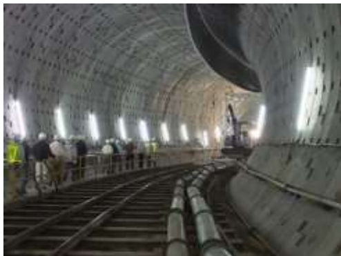
(写真7) 曲線部のセグメントが続く
