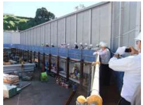
(写真4) 現場通路から見渡す。
