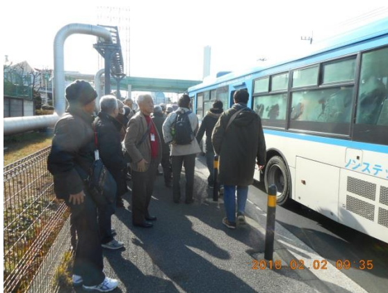
東電前のバス停から東電守衛所まで歩く。曲がったパイプは川崎火力発電所から供給している蒸気。近隣のコンビナート 10 社に供給されている。
