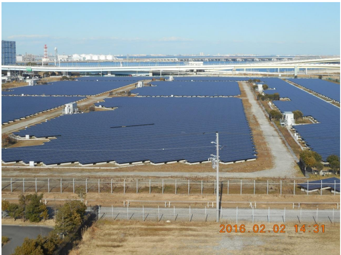
浮島の太陽光パネル。約 10ha。発電能力 0.7 万 KW
