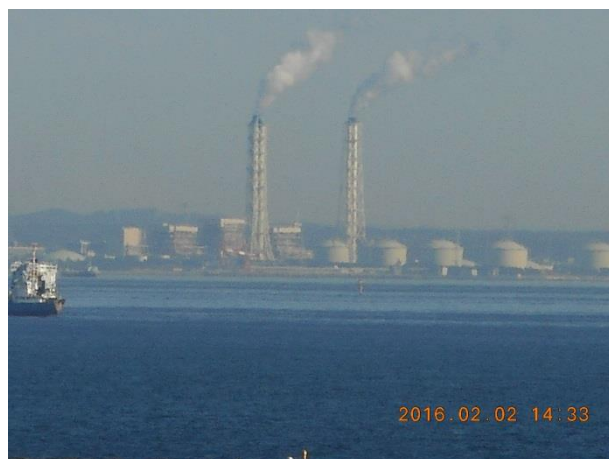
千葉の袖ヶ浦火力発電所
