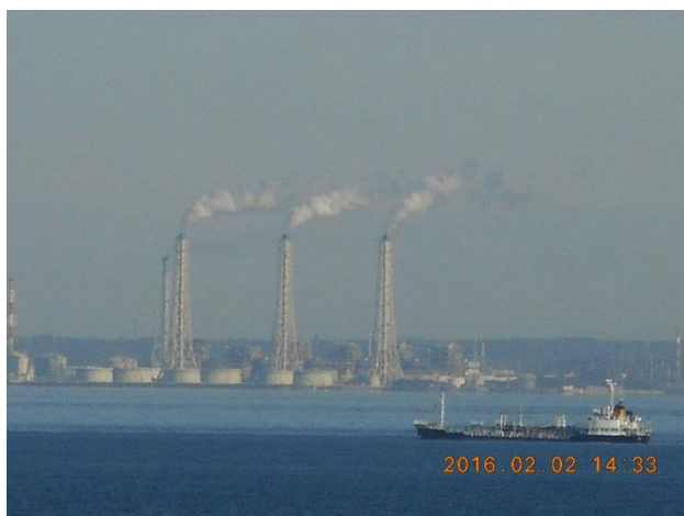
千葉の姉ヶ崎火力発電所
