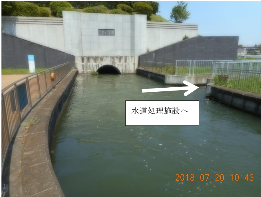
第一隧道からの着水井 ちやくすいせい …8時間かけて到達。ここで東京都と川崎の工業用水用と飲料水用に分岐する。
