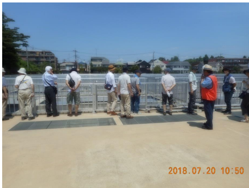
処理施設を巡る。活性炭接触池→沈殿池→ろ過池→配水池
