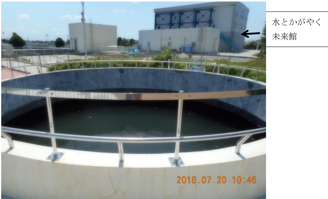
第二隧道の着水井
