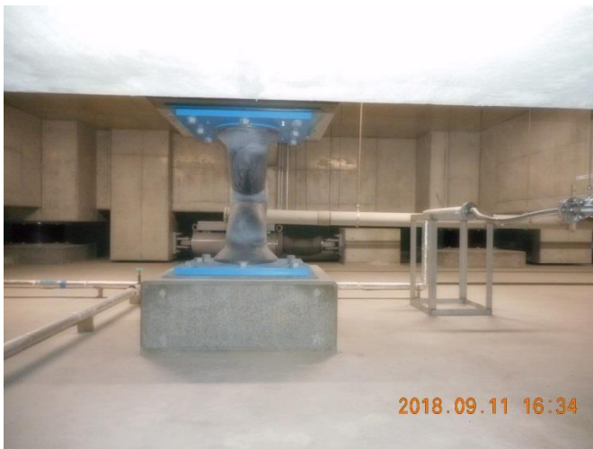
防災センターの免震装置の状況
