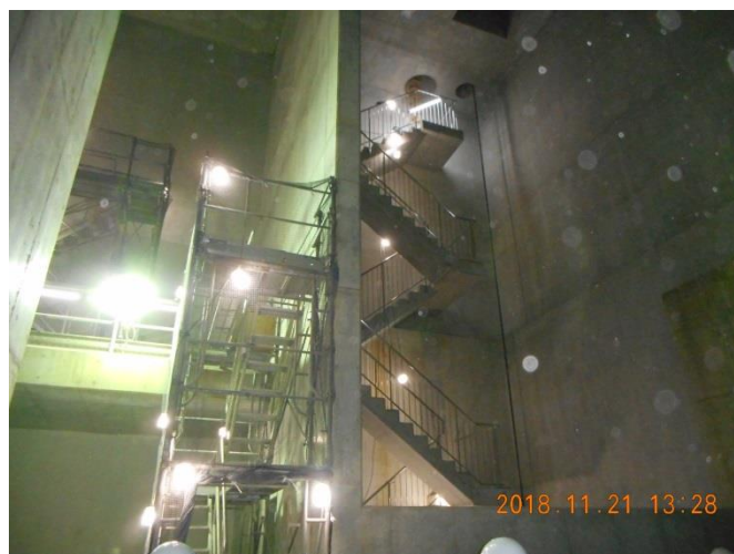
トンネル立坑部の昇降設備
