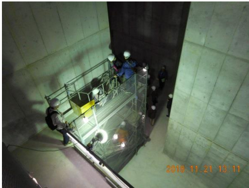
トンネル発進立坑内部の昇降階段を降りる。
