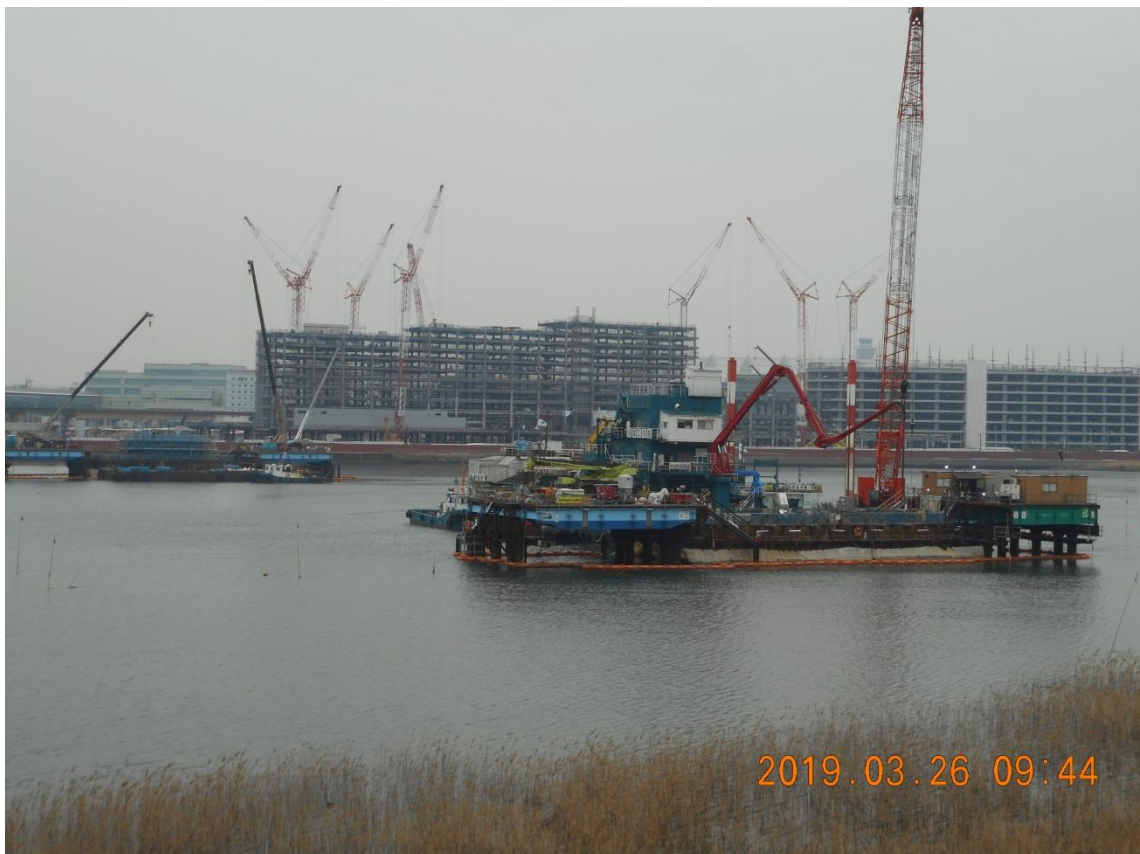
羽田連絡道の橋梁工事の現場風景。羽田側には客室 1700 人のホテルが建設中。
