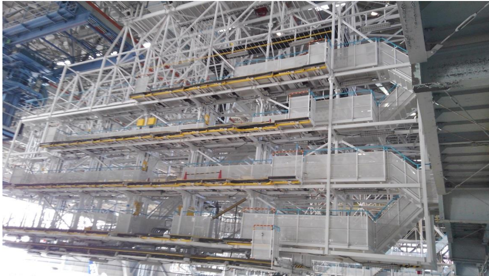
作業用足場。ドッグスタンド。
