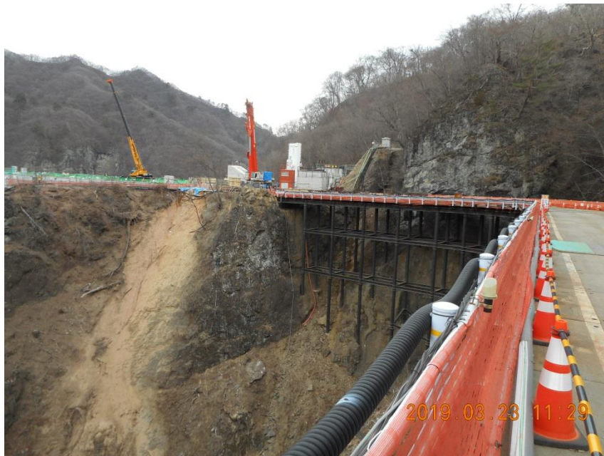
右岸側の工事進入路の様子。
