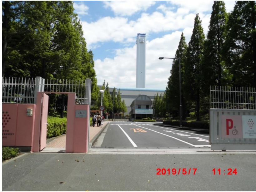
横浜火力発電所
