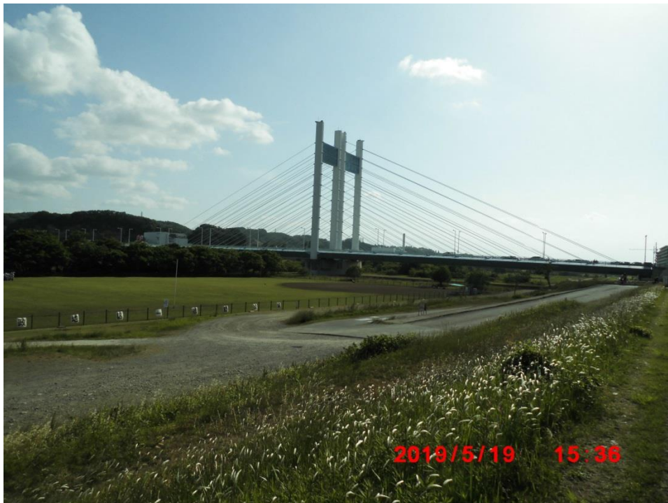
是政橋。全長 400m。府中市と稲城市を結ぶ斜張橋。
