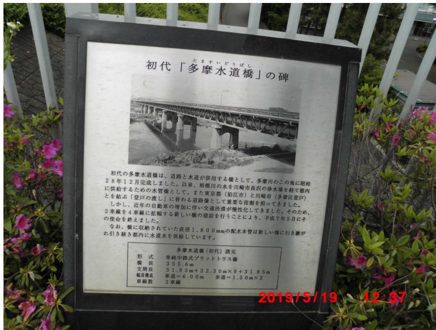
多摩川水道橋の碑。プラットラス橋。川崎の長沢浄水場から東京都へ配管 1800 mmで水の供給をしている。
