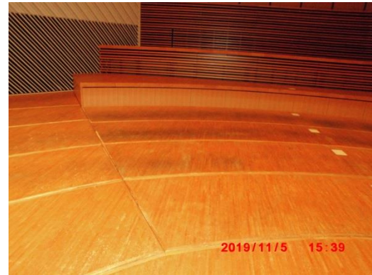
舞台のせり上がり状況とダウンしてフラットになった状況
