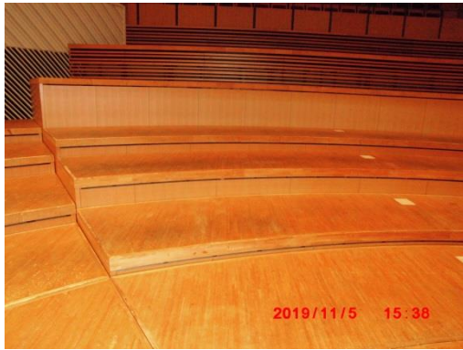
舞台のせり上がり状況とダウンしてフラットになった状況
