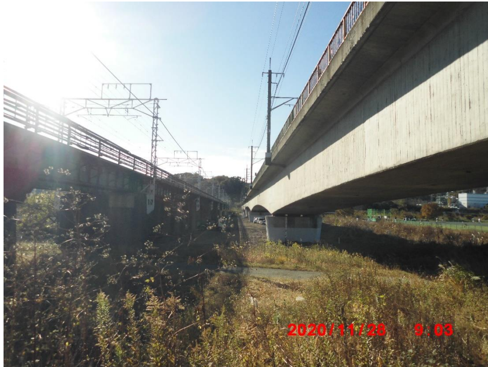
左側が南武線。右側が貨物線。
