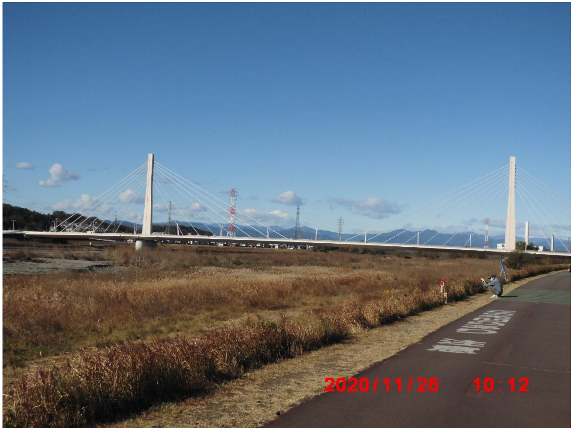
府中四谷橋。440m の斜張橋。右の府中市から左の八王子市方面を経て相模原市に至る。
