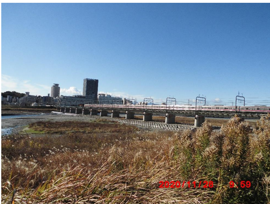
関戸橋を過ぎると京王線の橋梁が見えます。向こうのビル群は聖跡桜ヶ丘方面。多摩川の河口から35キロ地点です。
