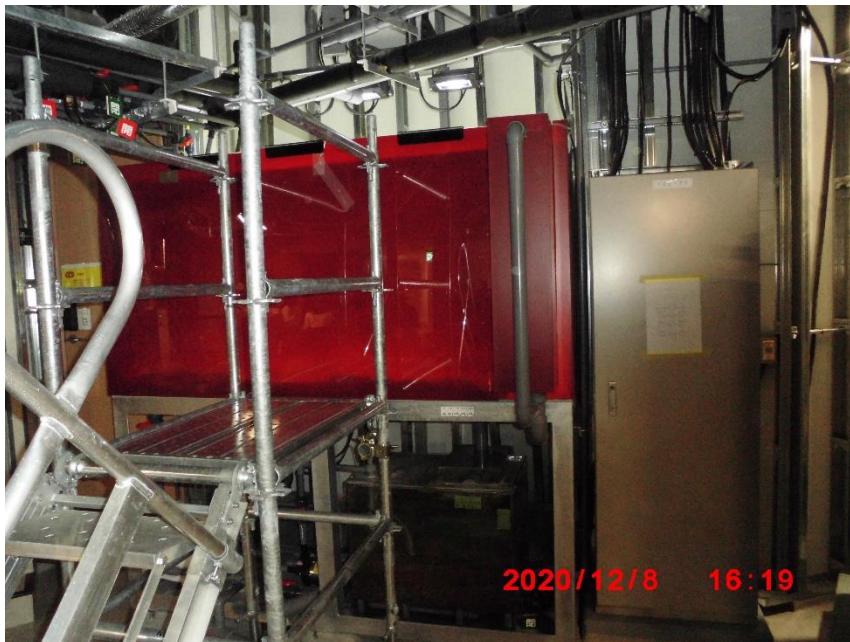
水族館のバックヤード。赤い色が水槽でこの中に魚がいて表側からみる水槽になっている。水槽の浄化や水の循環やえさを与える場所。
